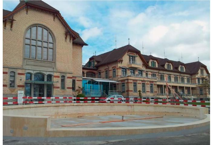
Die Brunnenverkleidung aus eingefärbtem Beton
